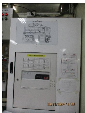
แผงควบคุมระบบสัญญาณแจ้งเหตุอัคคีภัย
