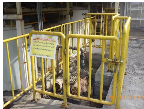
บ่อบำบัดน้ำและบ่อรวบรวม (Sump Pit)
