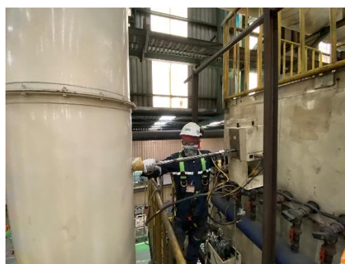
ปล่องที่ 10 การขัดผิวชิ้นงาน Line B2 No.2
