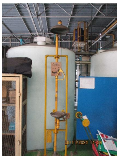
รูปที่ 2-42 อุปกรณ์ล้างตาและฝักบัวฉุกเฉิน ในบริเวณใกล้เคียงพื้นที่ปฏิบัติงาน
