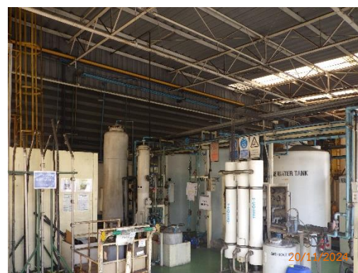
รูปที่ 2-26 ระบบบำบัดน้ำเสียทางเคมี ที่บริเวณ Final Tank
