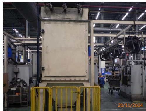
รูปที่ 2-13 Bag House Filter ขนาดเล็ก บริเวณการเจียรแต่ง
