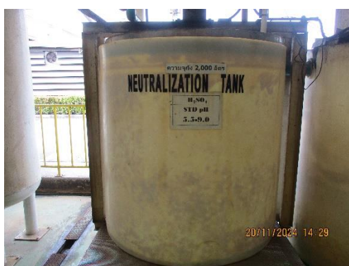
รูปที่ 2-24 ระบบบำบัดน้ำเสียทางเคมี
