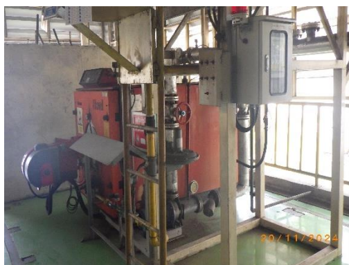
รูปที่ 2-14 ถังเก็บก๊าซธรรมชาติ (NG) เพื่อเป็นเชื้อเพลิงสำหรับหม้อไอน้ำ
