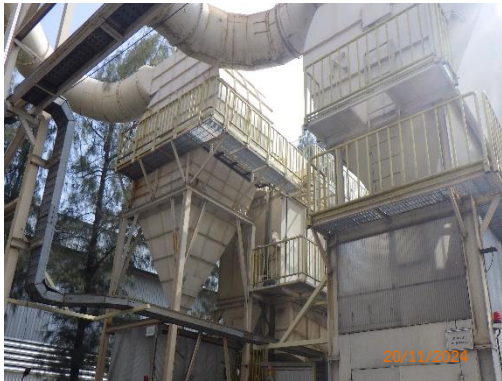
รูปที่ 2-4 เครื่องดูดอากาศ บริเวณการหลอมเหล็ก
