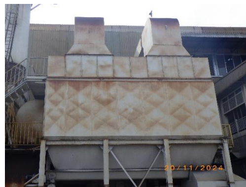
รูปที่ 2-11 Bag House Filter บริเวณการปั้นแบบและการขัดผิวชิ้น
