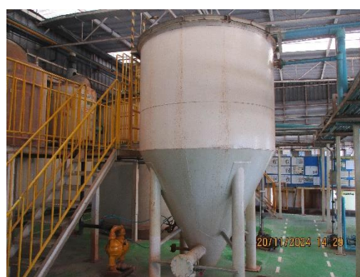
รูปที่ 2-24 ระบบบำบัดน้ำเสียทางเคมี
